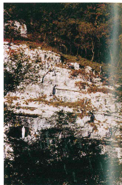
Una fase della bonifica della parete (si vedono in alto gli “operatori”) (foto Giorgio Potrich)
