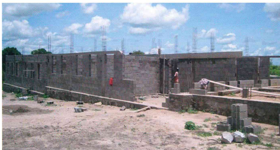
Il TAD in costruzione
