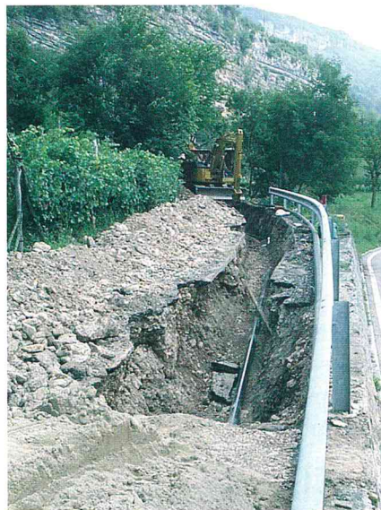
Posa tubazioni in frazione Vignala
