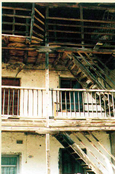
Elementi lignei di facciata (foto archivio comunale).
