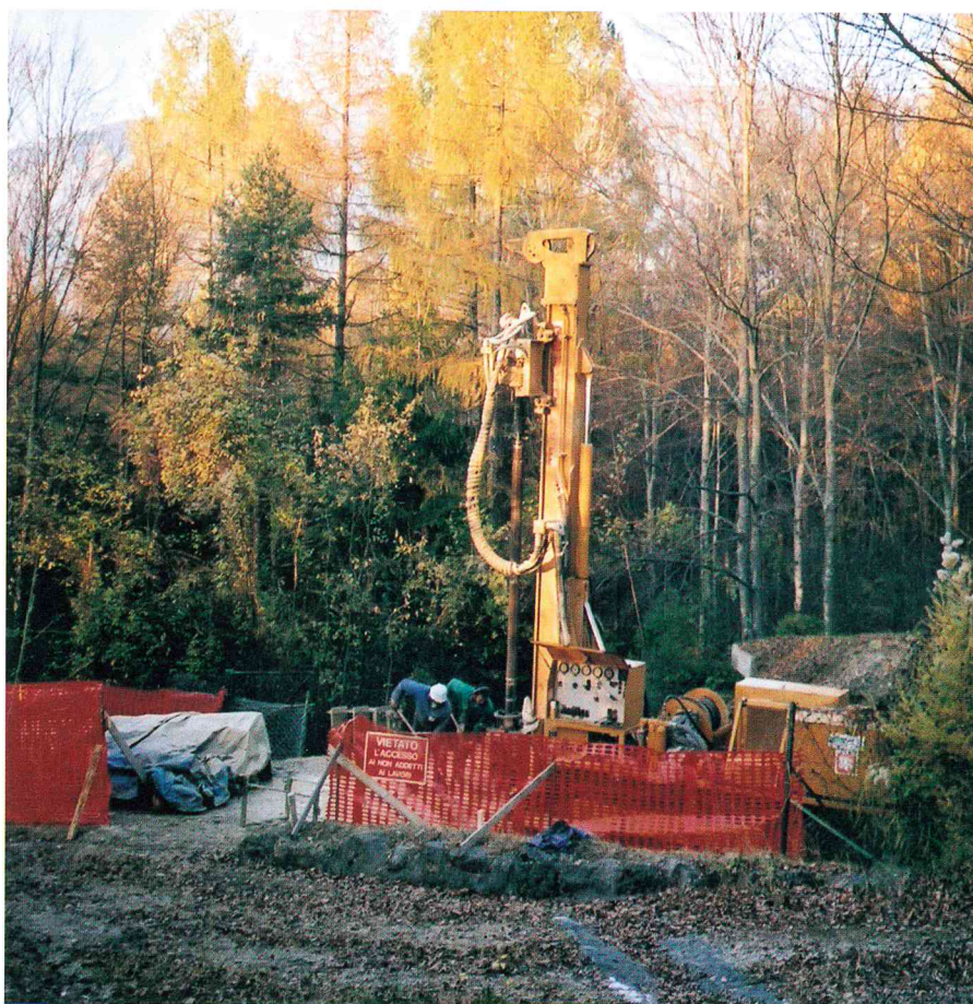
Allestimento cantiere e lavori di perforazione in loc. Spiazzi
