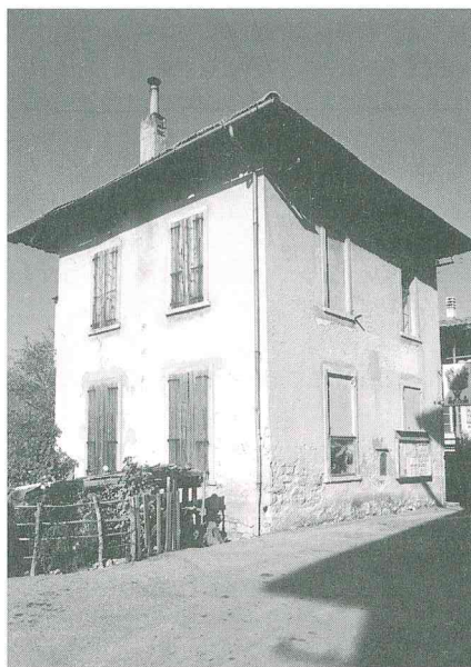
Ristrutturazione ex scuole Pozzacchio. (foto Angelo Marsilli)
