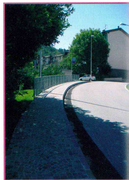
Tratto del nuovo marciapiede.
