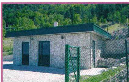
Il nuovo serbatoio a Boccaldo.
