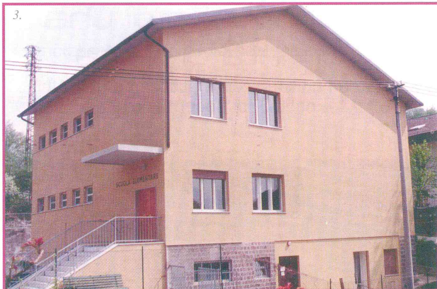
Scuola sopraelevata negli anni '80 (rispetto alla situazione attuale manca l'ascensore esterno).
