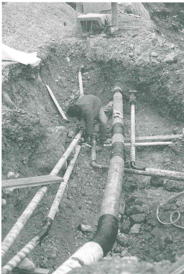
Lavori per la posa di varie tubazioni.
