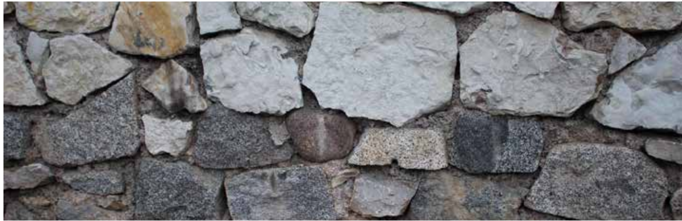
Esempio di muro in finto-secco con pietre di provenienza non locale (foto A. Sarzo).
