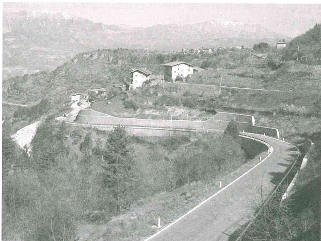
Nuova viabilità comunale in Frazione Boccaldo.
