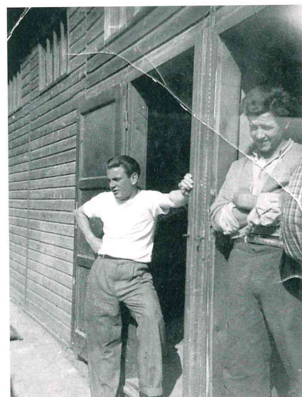
Val Senales, anni 1950-55, Giuseppe e Elio Bisoffi davanti la baracca del cantiere in cui dormivano
