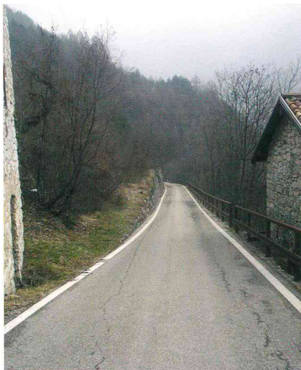
Tratto della strada provinciale in località Casotte a Vanza
