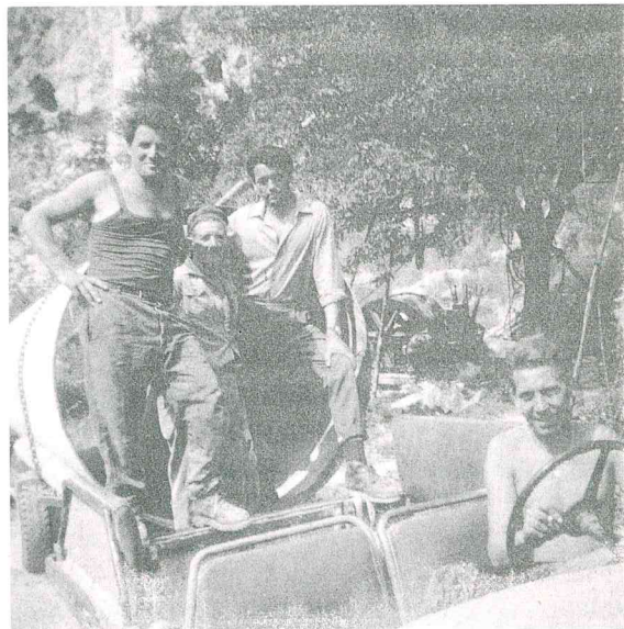
Trasporto delle condotte alla Diga di S. Colombano
