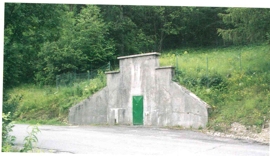
Serbatoio di Pozza
