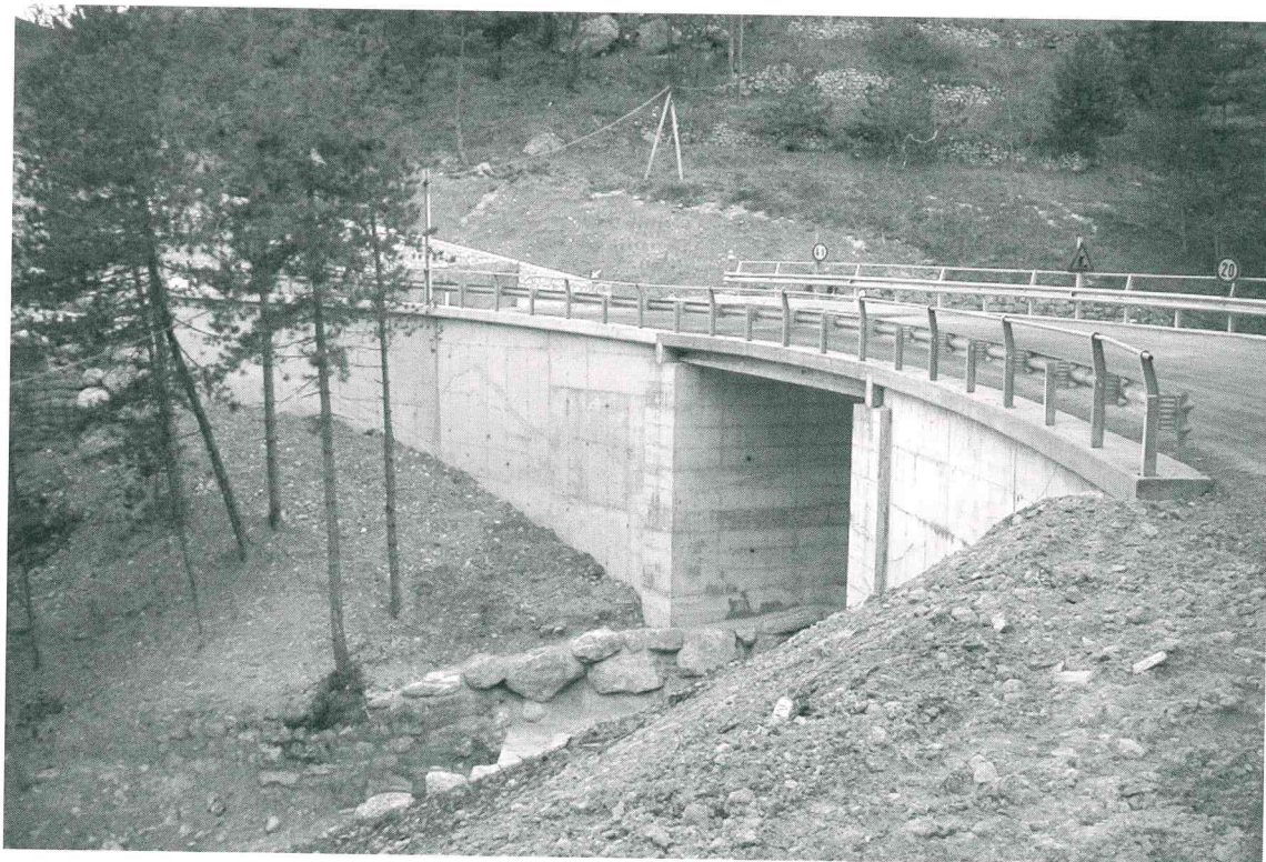
Nuovo ponte sul Rio Orco.
