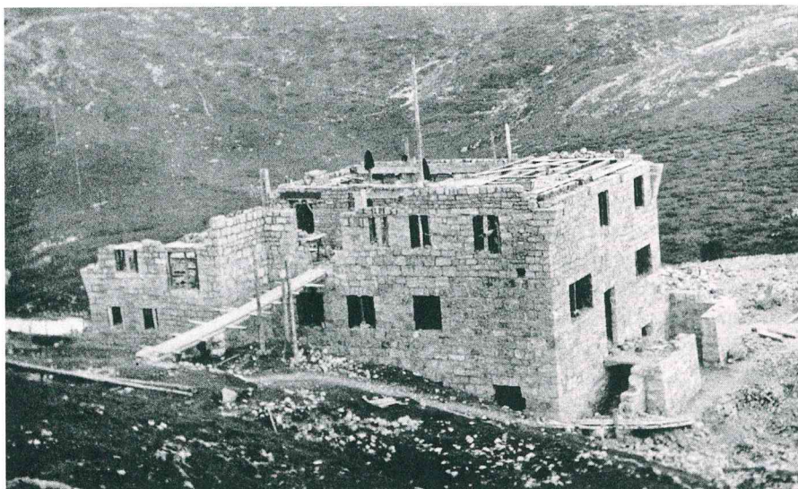
La costruzione del Rifugio Lancia
