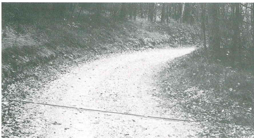
La strada rurale con posa di canalette presso il "Tambarer".
