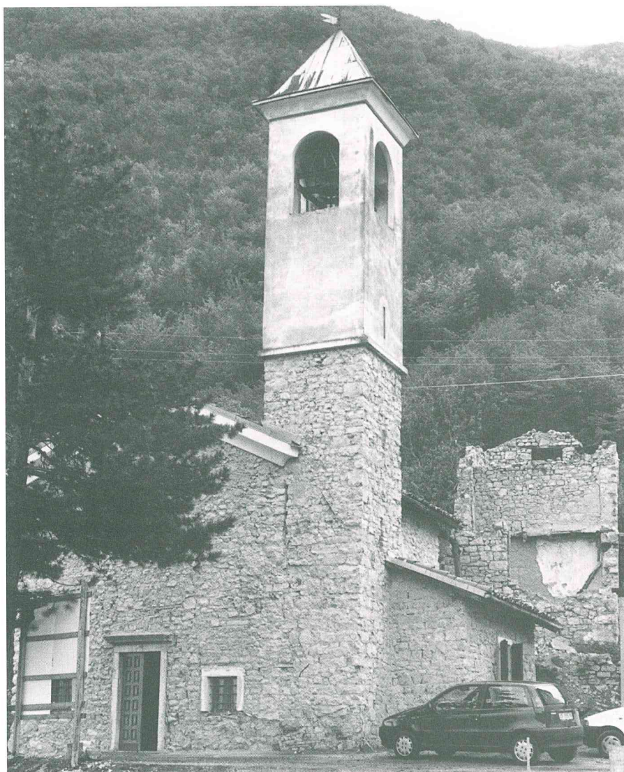
Maggio '98: La Chiesa in fase di restauro.
