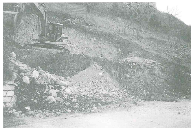
Lavori di scavo per la costruzione autorimessa atesina a Pozzacchio.
