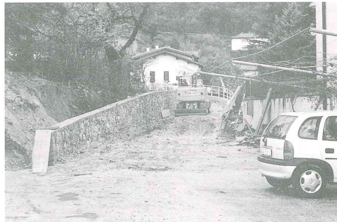
Lavori per la nuova viabilità di Porte.
