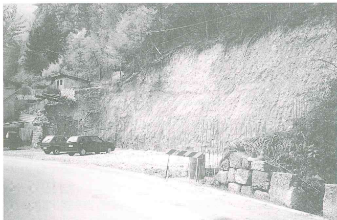
Il parcheggio in costruzione a Spino.
