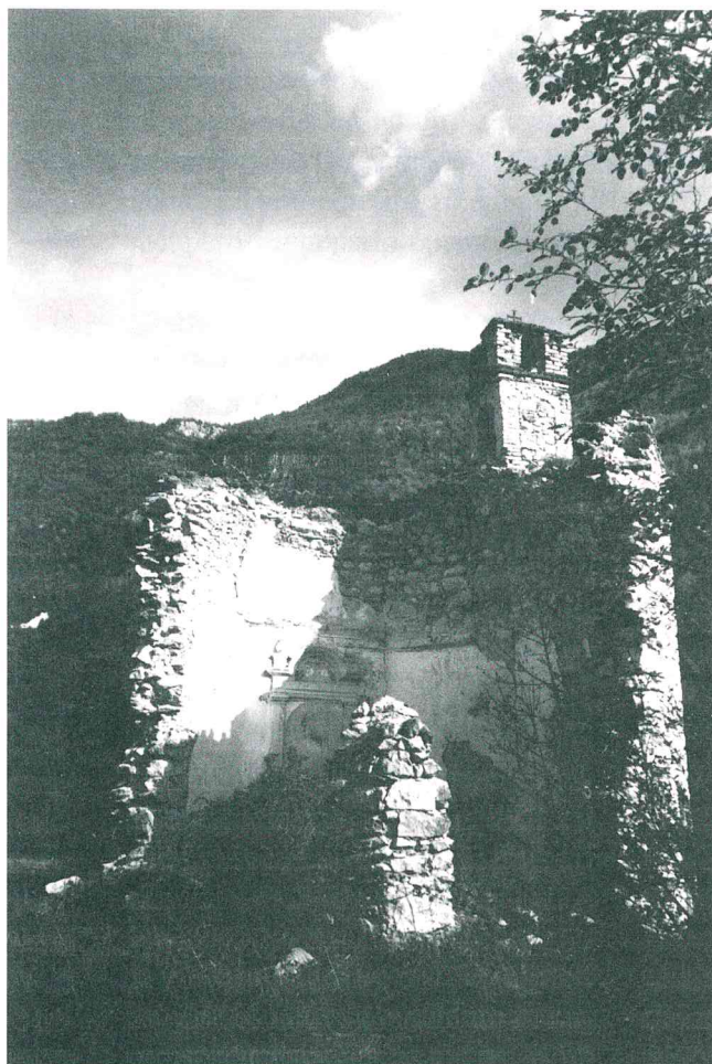
Lo stato di degrado della Cappella.
