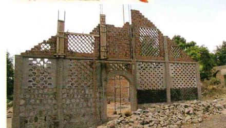
Chiesa che padre Beniamino sta costruendo
