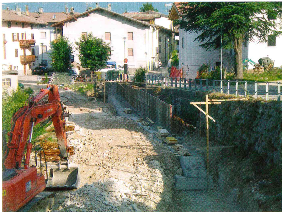
Iniziati i lavori della strada e parcheggio a Pozza
