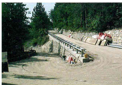
Lavori nel tratto di collegamento con la S.S.46 del Pasubio.
