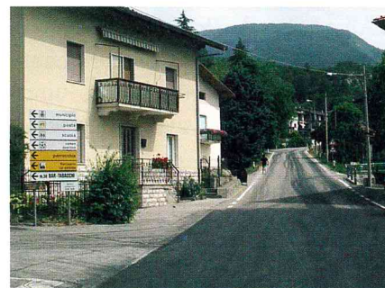
Il tratto di strada provinciale del nuovo marciapiede.
