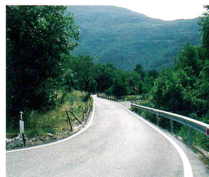
Tratto dell'attuale strada provinciale presso Vanza.
