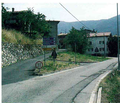
Realizzazione parcheggio nella frazione di Vanza.
