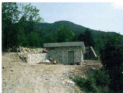
Il nuovo serbatoio di Boccaldo.
